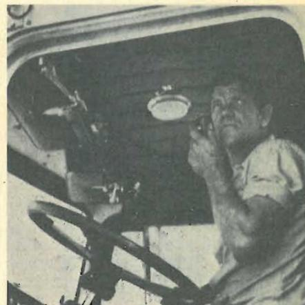
Fig. 2 "Bodacious", il suo "avversario" camionista. In genere, i radiotelefonici CB, nei camion U.S.A. sono montati sopra l'aletta parasole, come in questo caso, i "lineari" invece sono nascosti dietro al posto di guida.
